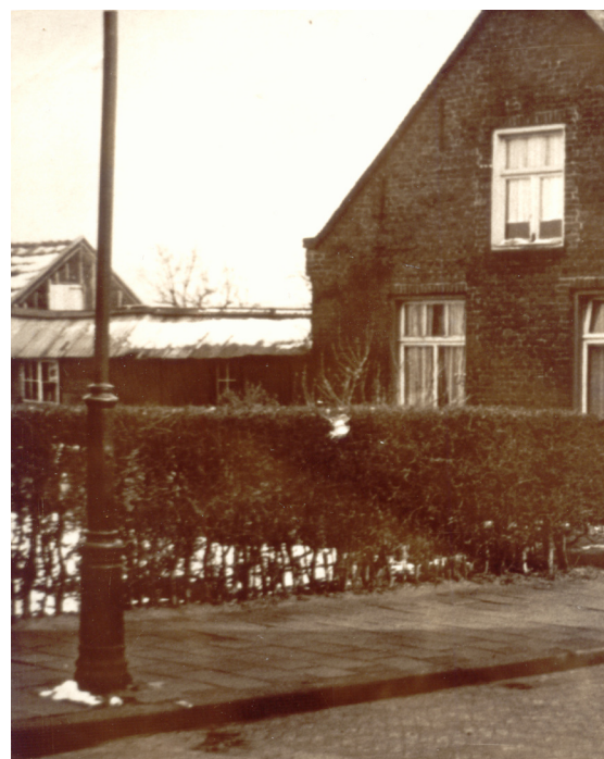
Blik op de Oude Goorstraat voor de bouw van
