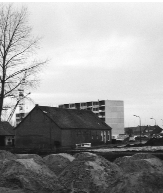
nieuwbouw in Coevering West
