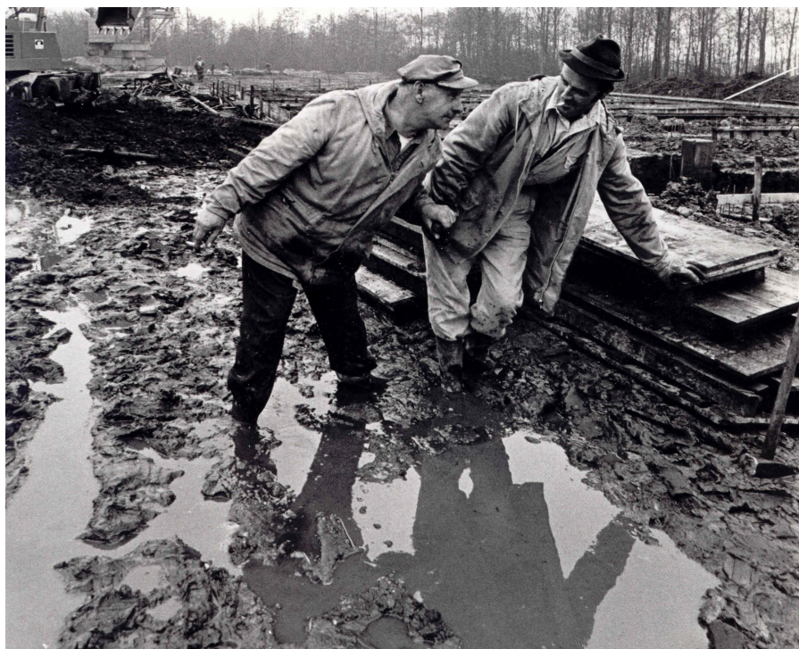
Nattigheid tijdens de bouw van Coevering West
