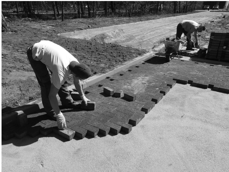
Het aanleggen van de bestrating ging in een vlot tempo
