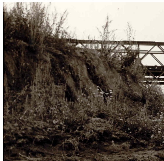
De oude Baileybrug over de Dommel voordat de Coevering er was.
