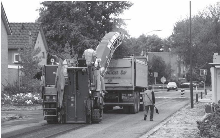
Werkzaamheden aan de Bosrand
